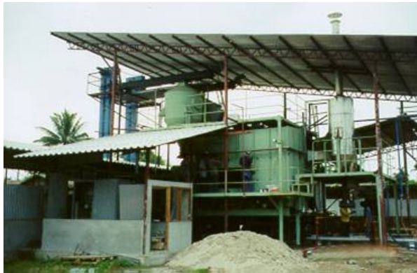
หม้อไอน้ำฟลูอิดไดซ์เบด 2 t/h ที่โรงงานหลวงอาหารสำเร็จรูป (ตอยคำ 2)
